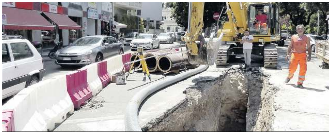
Sopra, il sindaco Carlo Salvemini. A sinistra, ruspe di Aqp al lavoro sulla rete di fognatura nera lungo via Cavallotti
