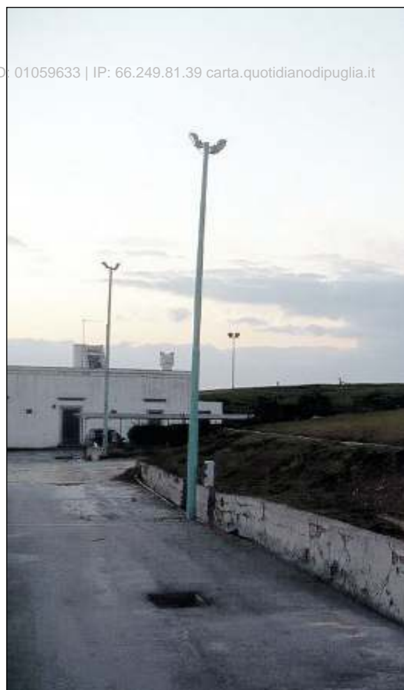
Sopra l'impianto di Castellino, ancora non completamente bonificato e accanto un impianto di compostaggio come quello che sorgerà a Nardò o a Soleto
